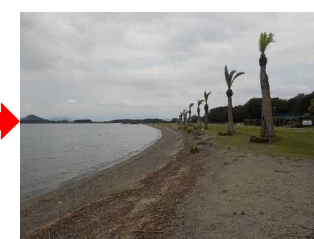
施工後（R4.5月）
