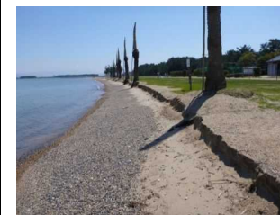
施工前（H24.4月）
